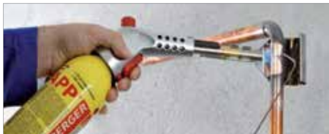
Пайка твёрдым припоем при монтаже системы газоснабжения
