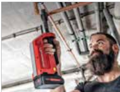
Twin Turbo при монтаже внутридомовых сетей
